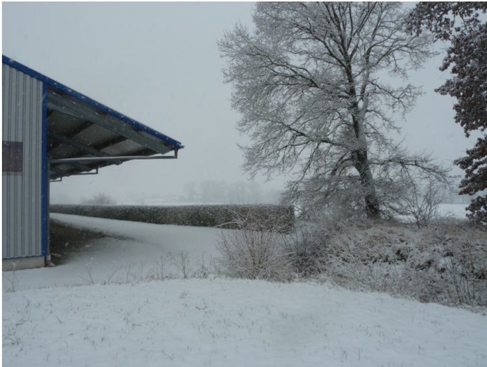
Abb. 18: Ansicht von Westen – Bestand, Baumgruppe und privater Entwässerungsgraben, Foto Jocham + Kellhuber (Dezember 2021)
