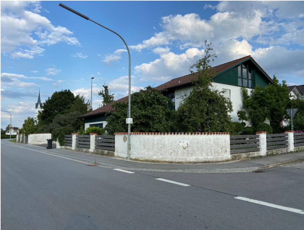
Abb. 2: Ansicht von Nordwesten - Bestandsgebäude Flur-Nr 3/1, Einmündung „Pfarrsiedlung“ in Massinger Straße; (Foto Jocham + Kellhuber, Juli 2022)
