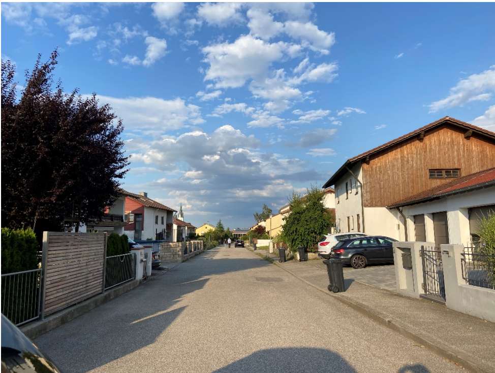
Abb. 3: Ansicht von Norden - umgebende Bebauung entlang „Pfarrsiedlung“; (Foto Jocham + Kellhuber, Juli 2022)
