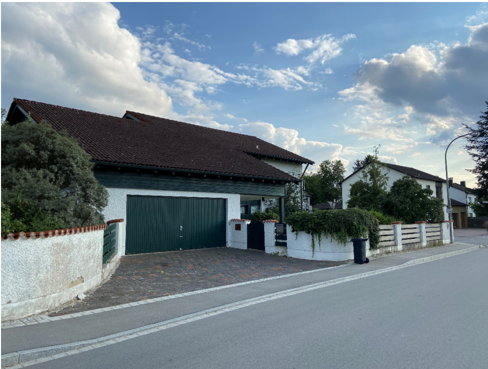
Abb. 16: Ansicht von Nordosten - Zufahrt Bestandsgebäude Flur-Nr 3/14; (Foto Jocham + Kellhuber, Juli 2022)
