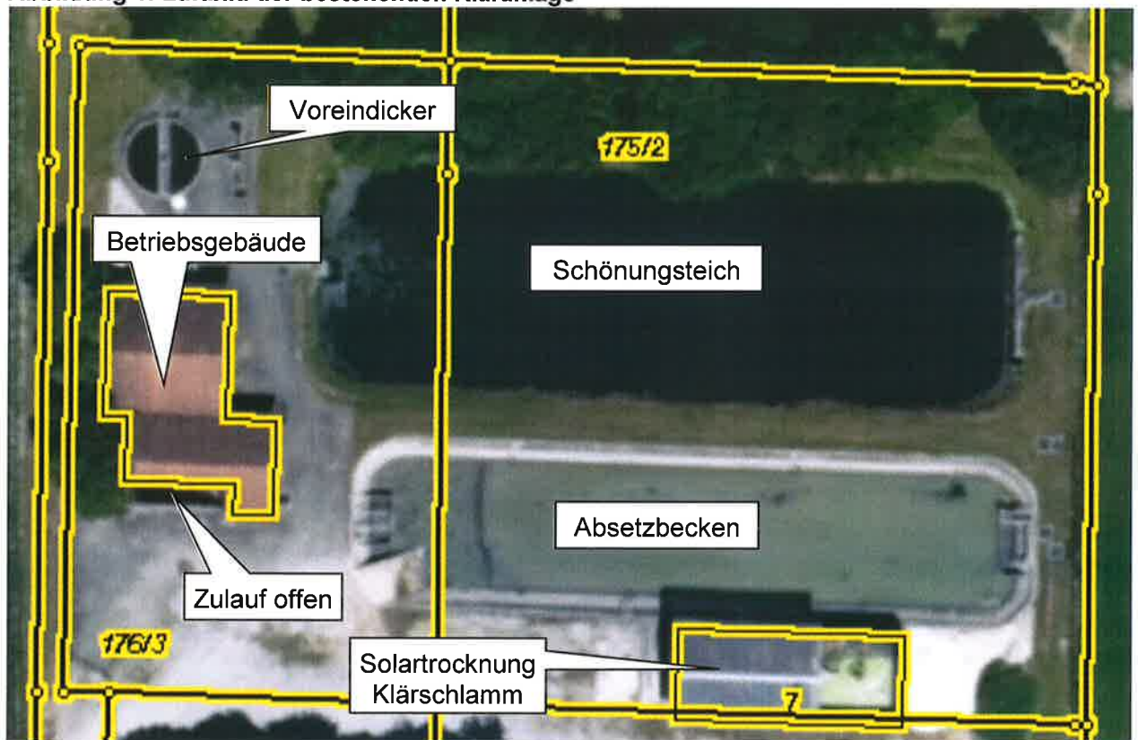
Abbildung 1: Luftbild der bestehenden Kläranlage
